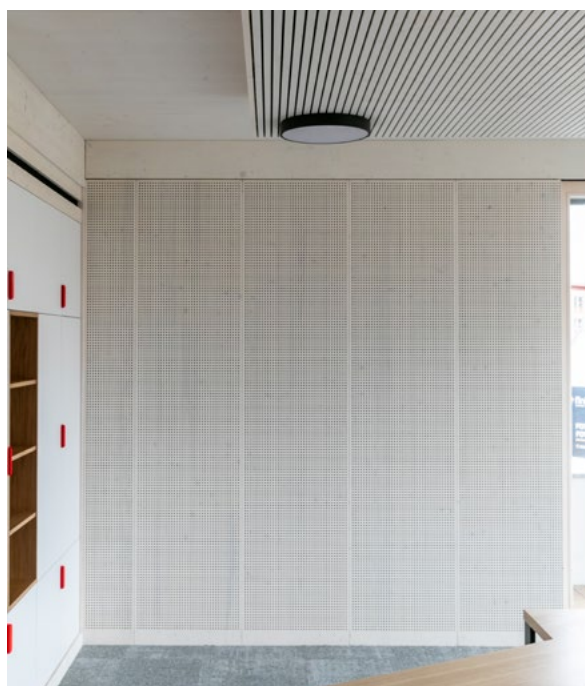
Profils percés avec traitement de surface
